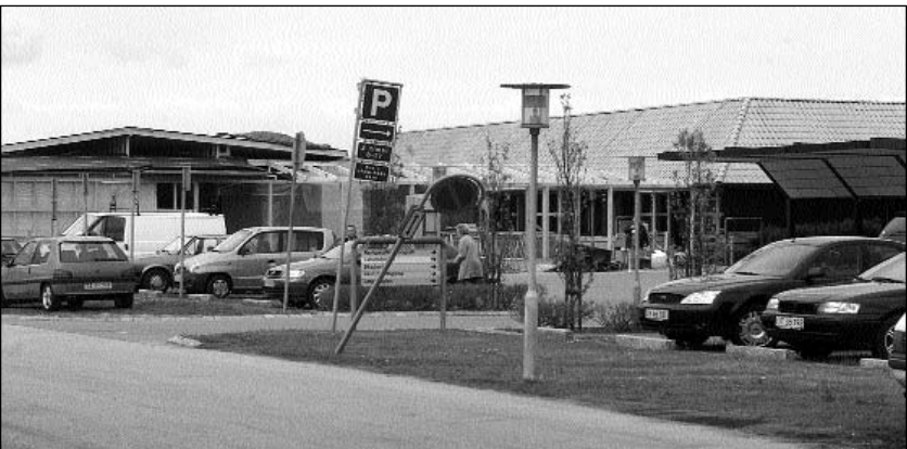
Die Arbeiten an und in den Pavillonen laufen am Apenrader Krankenhaus unter Hochdruck. (Foto: Karin Riggelsen)
